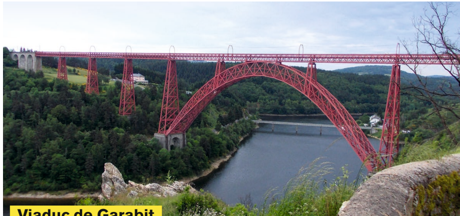
Viaduc de Garabit
