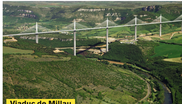
Viaduc de Millau
